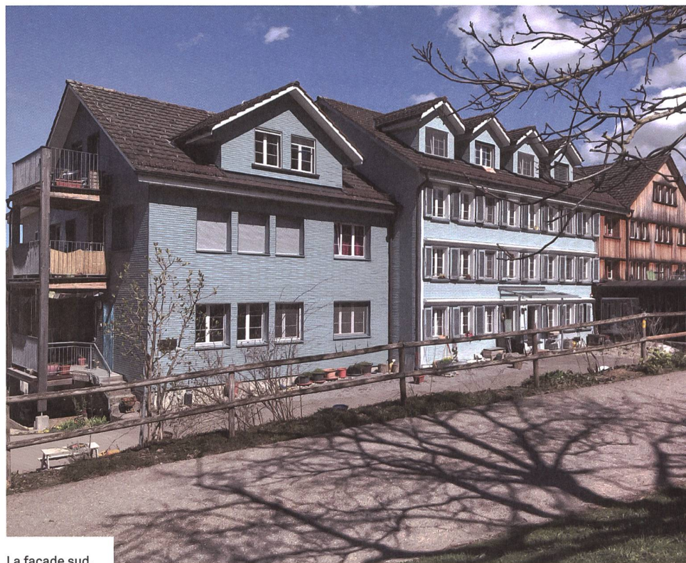
La façade sud.
