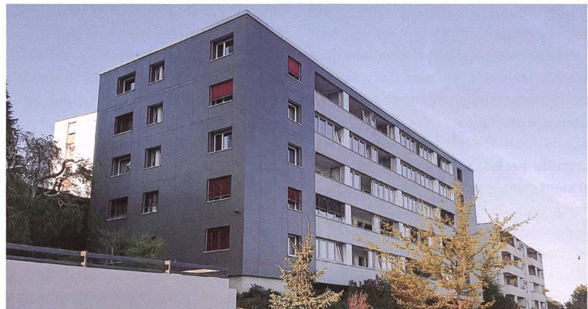
Les travaux réalisés rue Pierre-de-Vingle à Neuchâtel ont été: isolation des façades et de la toiture, fermeture des balcons, ajout d'un ascenseur (sous-sol au rez), réfection des cages d'escaliers, remplacement des portes palières. Coût: Fr. 1 190 000.– (Avant en haut, après en bas)
