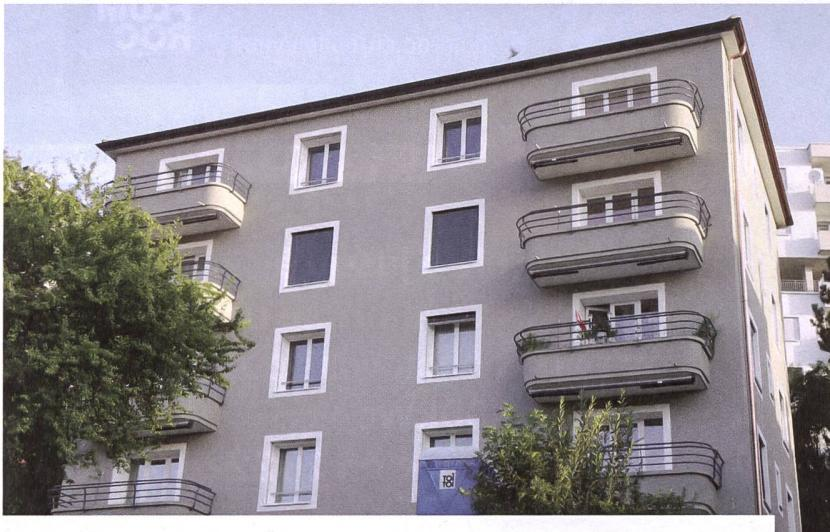
Les travaux réalisés rue des Fahys à Neuchâtel ont été: isolation des façades, remplacement des ferblanteries, pose de stores électrifiés, réfection des cages d'escaliers. Coût: Fr. 560 000.– (pour les deux immeubles) (Avant en haut, après en bas)
