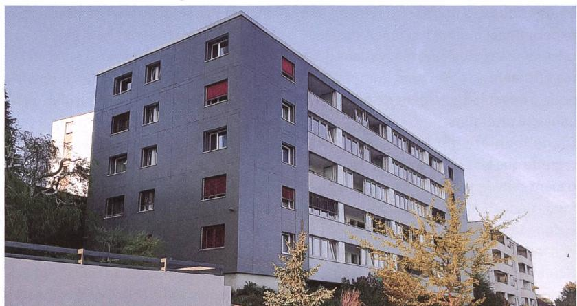
Les travaux réalisés rue Pierre-de-Vingle à Neuchâtel ont été: isolation des façades et de la toiture, fermeture des balcons, ajout d'un ascenseur (sous-sol au rez), réfection des cages d'escaliers, remplacement des portes palières.
