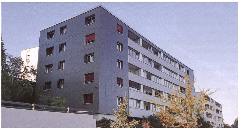
Les travaux réalisés rue Pierre-de-Vingle à Neuchâtel ont été: isolation des façades et de la toiture, fermeture des balcons, ajout d'un ascenseur (sous-sol au rez), réfection des cages d'escaliers, remplacement des portes palières. Coût: Fr. 1 190 000.– (Avant en haut, après en bas)
