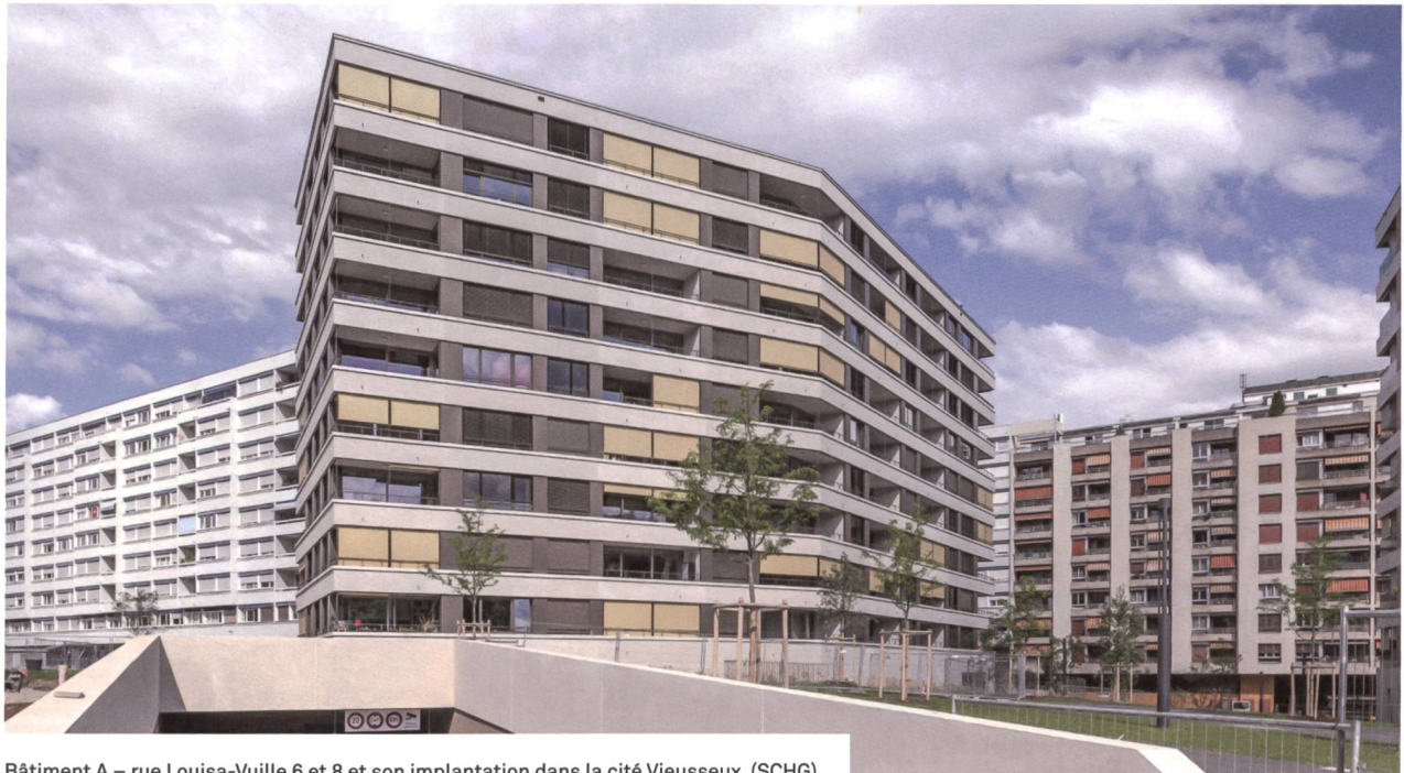
Bâtiment A – rue Louisa-Vuille 6 et 8 et son implantation dans la cité Vieusseux. (SCHG)
