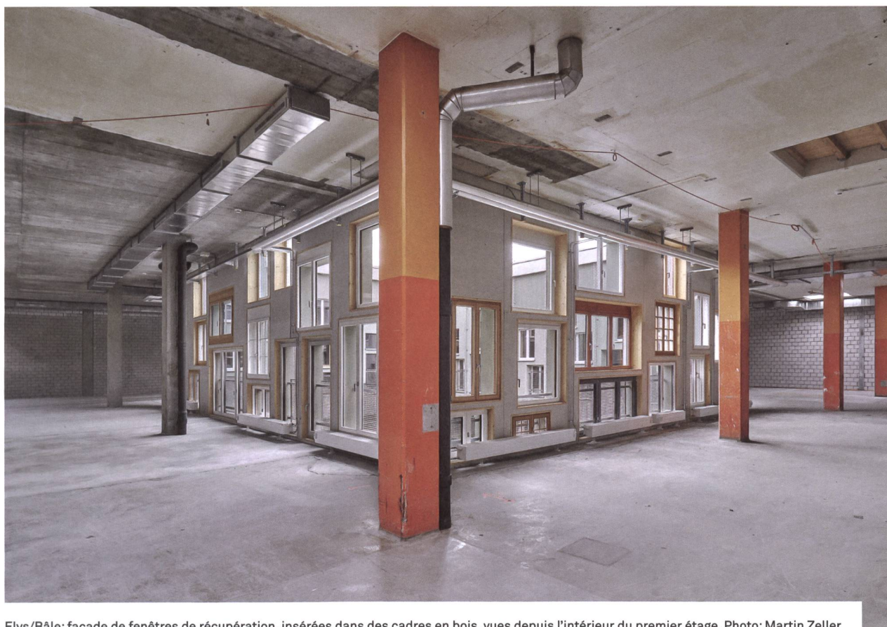
Elys/Bâle: façade de fenêtres de récupération, insérées dans des cadres en bois, vues depuis l'intérieur du premier étage. Photo: Martin Zeller
