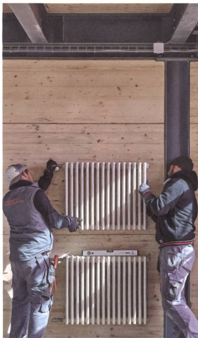
K118: montage de radiateurs récupérés dans l'ancienne imprimerie de Winterthur. Photo: Martin Zeller
