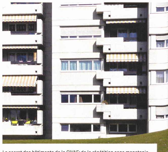
Le secret des bâtiments de la CIVAF: de la répétition sans monotonie.
