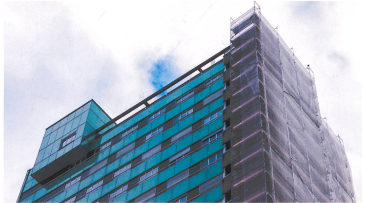
La tour Bournot se transforme pour accueillir des appartements avec encadrement et des logements familiaux.
