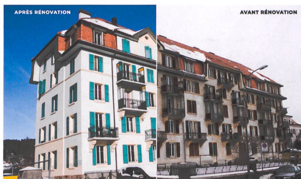
La coopérative de La Renouveau: rénovation complète au label Minergie, qui respecte le patrimoine UNESCO.
