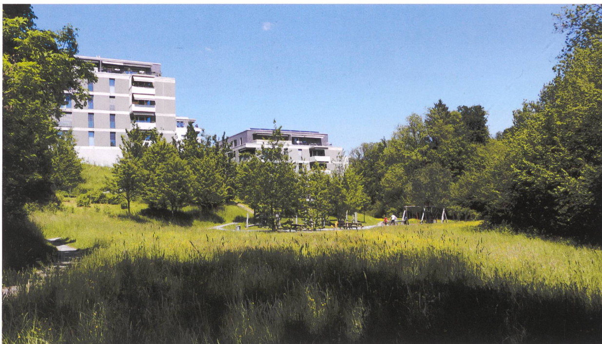
L'entretien des surfaces situées autour des immeubles des coopératives d'habitation est très souvent confié à des jardiniers-paysagistes professionnels. DR/SCHL
