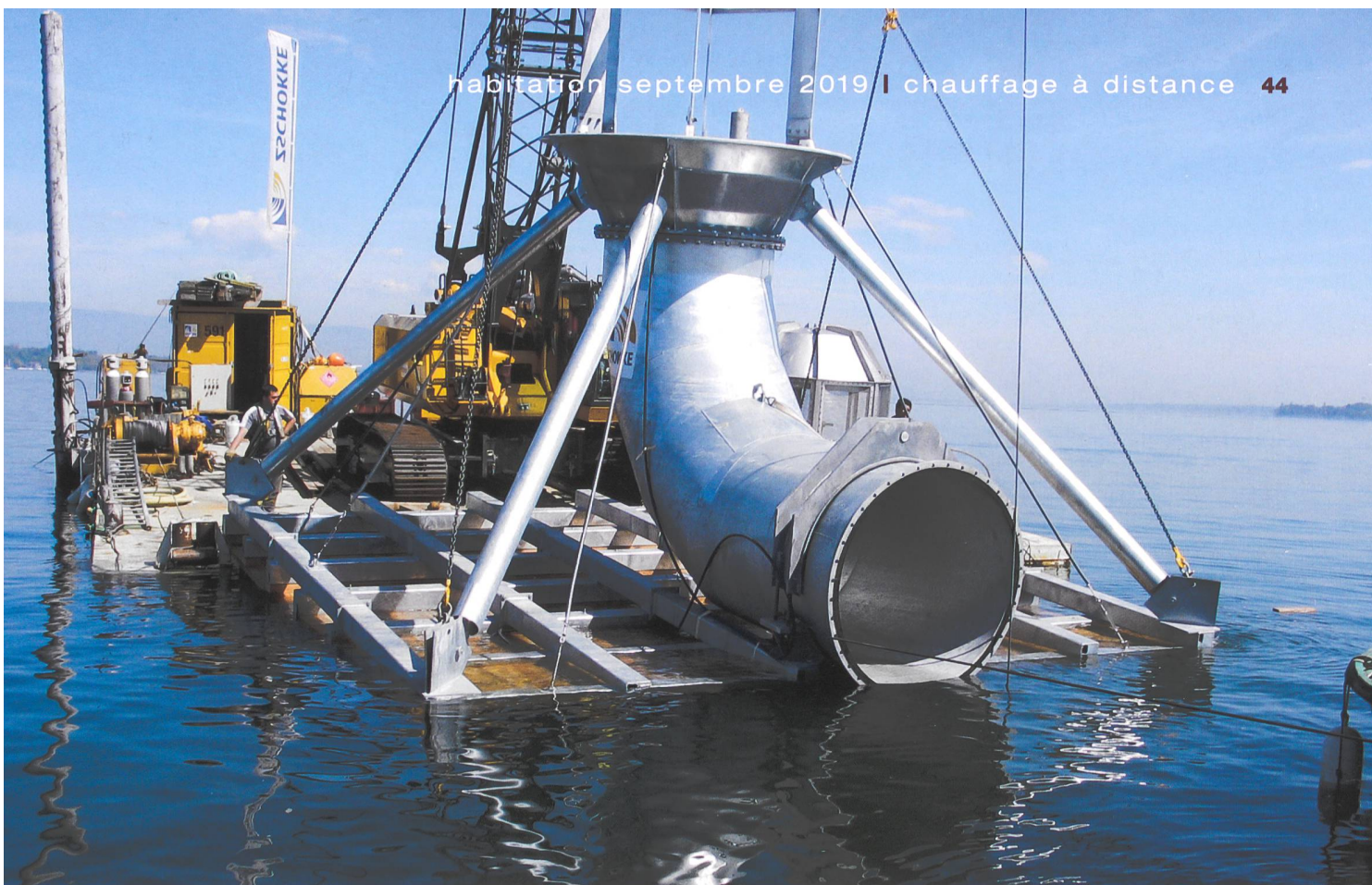
Crépine en train d'être descendue et posée au fond du lac Léman. DR/Genilac
