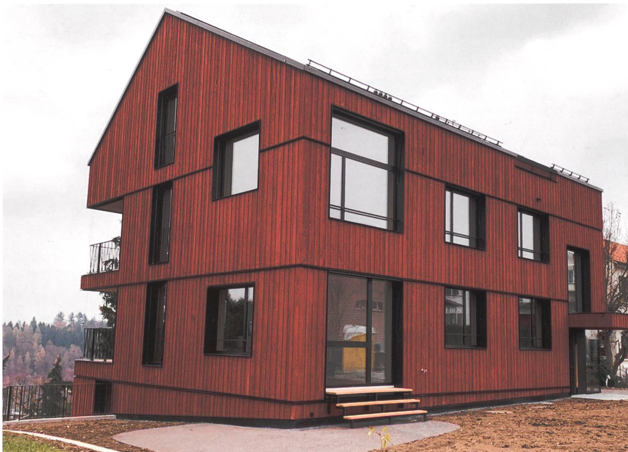
Les façades de cette maison ont été revêtues d'une peinture extérieure naturelle très résistante». Photo Falu Vapen/DR
