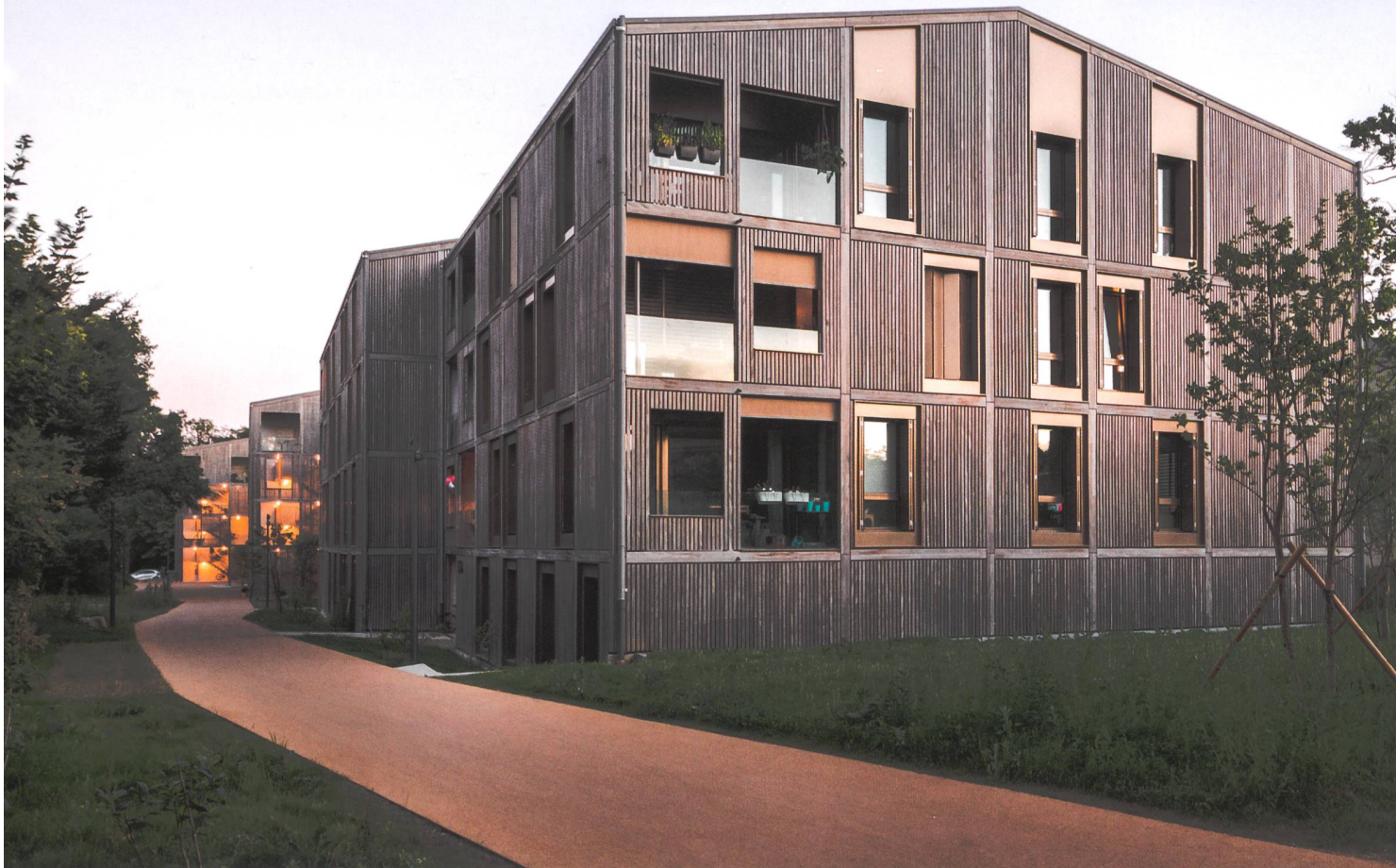
Par sa morphologie, l'ensemble assure la transition entre les immeubles et les villas qui l'entourent. Bonhôte Zapata/DR
