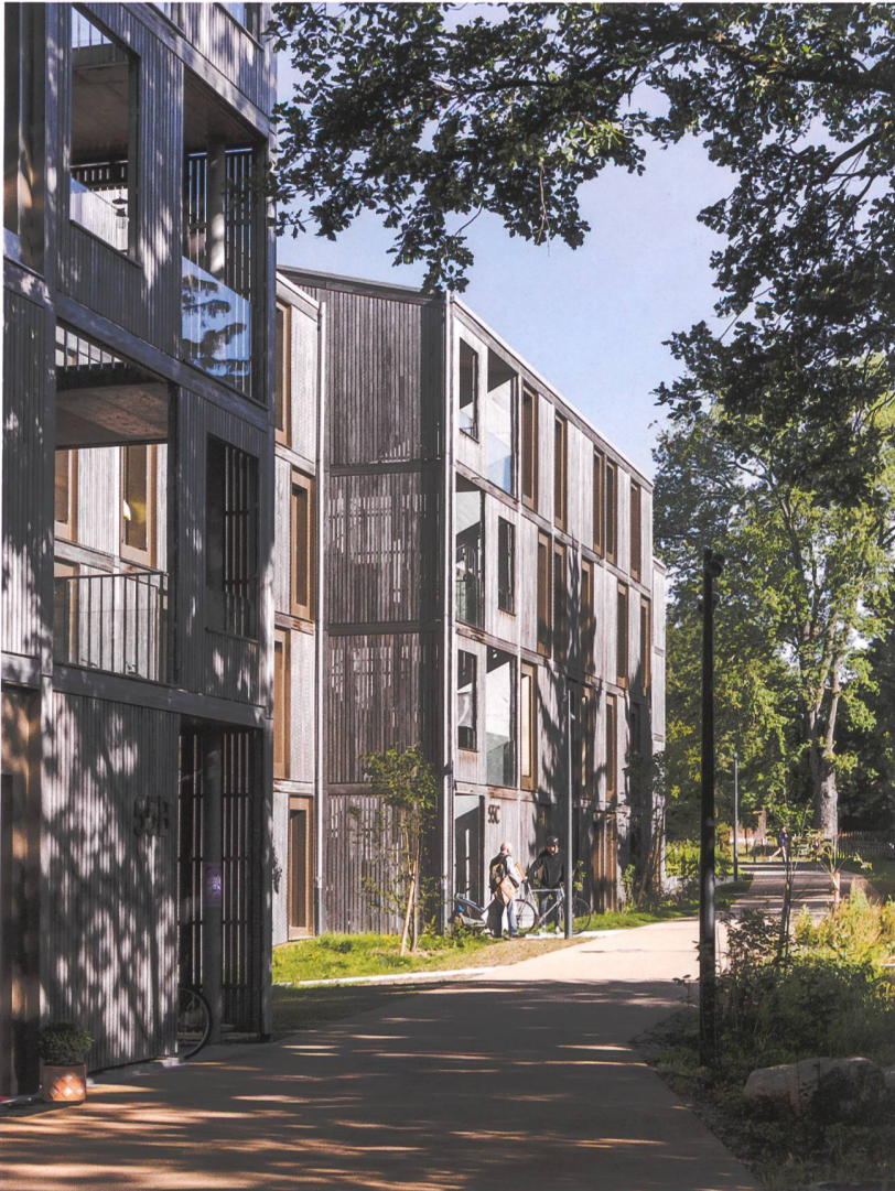
Par sa morphologie, l'ensemble assure la transition entre les immeubles et les villas qui l'entourent. Bonhôte Zapata/DR
