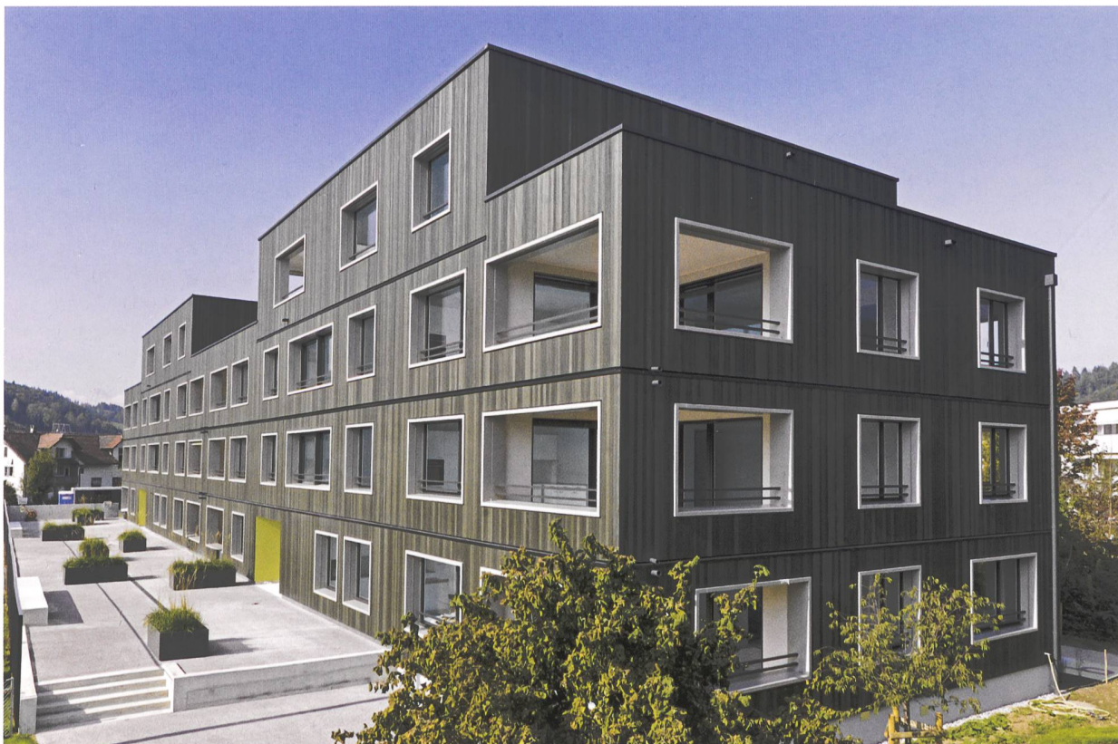
Il est maintenant possible de construire des immeubles locatifs entièrement en bois, à l'exemple de la Swisswoodhaus à Nebikon. © Renggli SA
