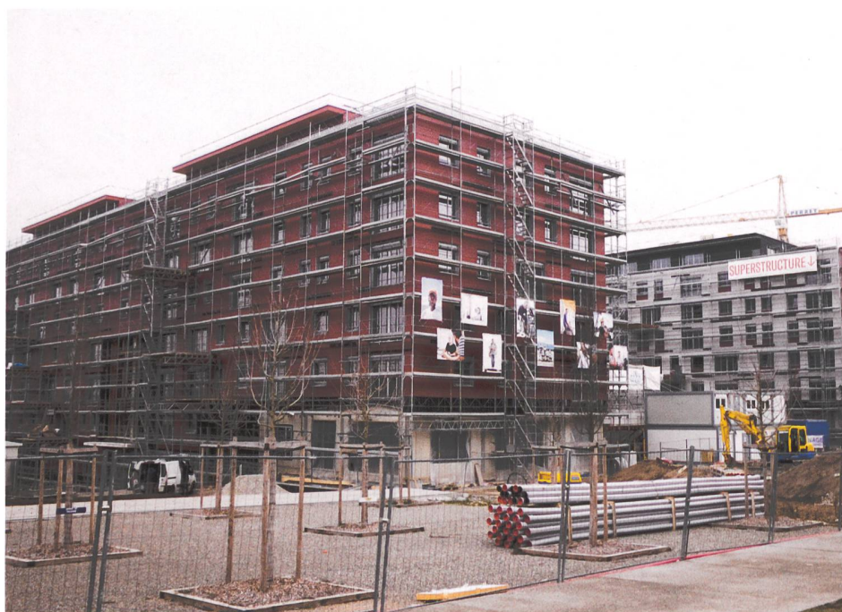
Pour ce bâtiment hybride (Les Vergers à Meyrin), la structure porteuse est en béton et les éléments de façade sont à ossature bois, de même que les attiques. © Bellmann, bureau d'architectes, Montreux
