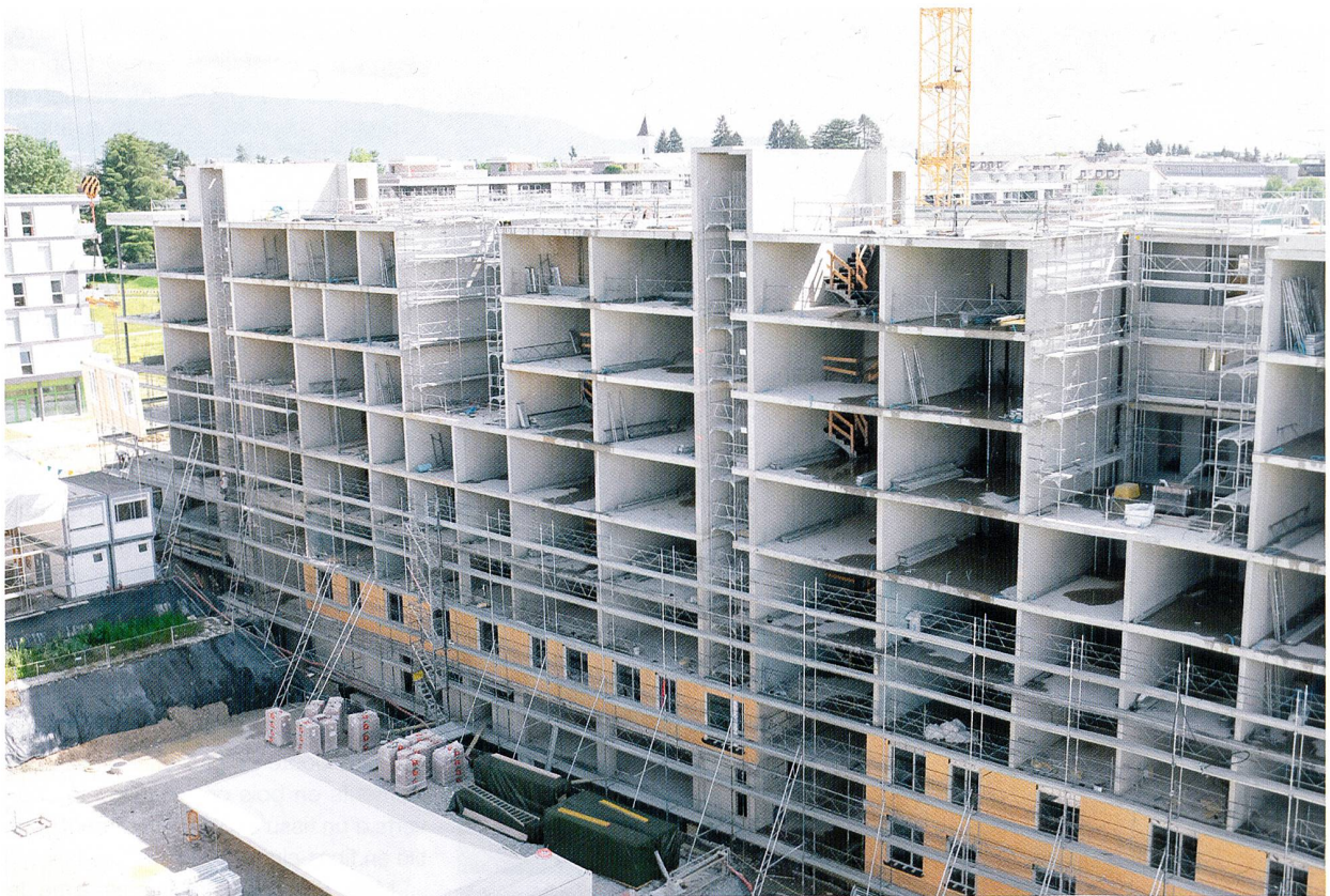
Les éléments sont montés directement sur le squelette en béton de l'immeuble. Bellmann/DR
