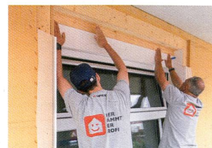
Le système Implio de raccord de fenêtre étanche au vent et à la pluie battante offre l'avantage de réaliser le raccord de fenêtre avec bandeau (panneau de linteau), caisson de volet roulant et/ou de store à lamelles et panneau d'habillage Rivestio ainsi que panneau d'embrasure et en biseau comme deuxième niveau d'étanchéité directement lors de la pose de l'isolation.
