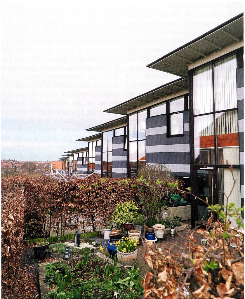
Le lotissement de Grønhoi avec ses logements sociaux fait partie d'un quartier mêlant logements en propriété et en location.
