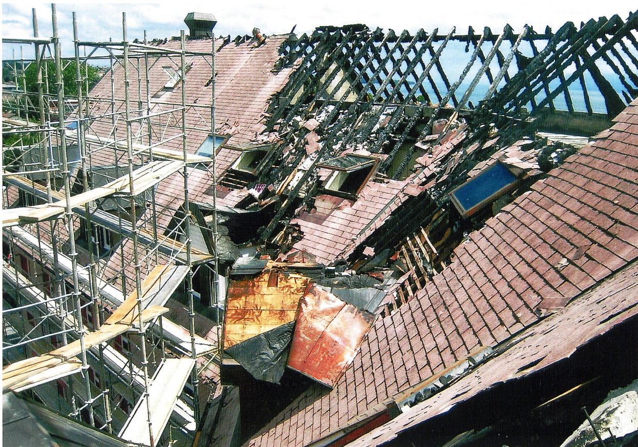
Très vite, la coopérative a fait installer des échafaudages pour pouvoir commencer les déblaiements. SCHR
