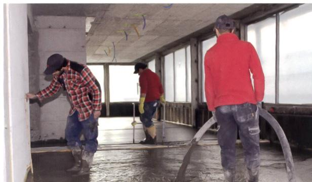
Grâce au haut rendement de pose ainsi qu'à l'application facile du matériau, une équipe de seulement trois personnes peut appliquer le mortier mousse sur cette surface de plus de 4000 mètres carrés (© Fixit AG).
