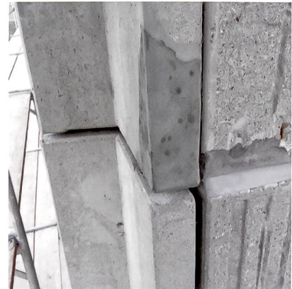
Traitement de la carbonatation. DR
