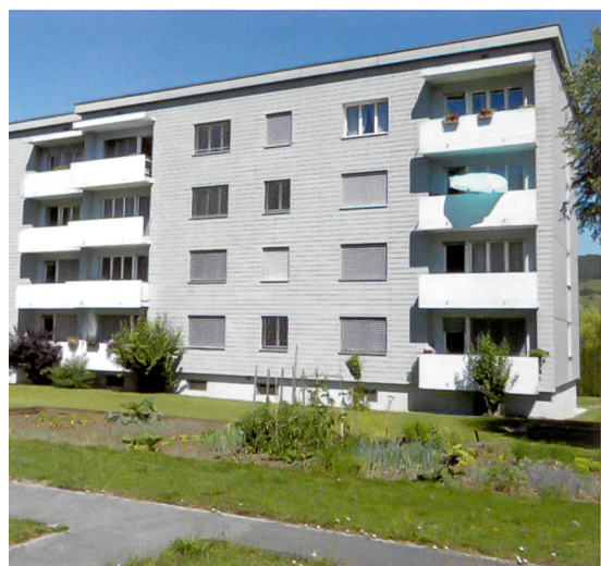
L'immeuble de la Société coopérative de construction SORALI à Courtételle. © D. Gunzinger
