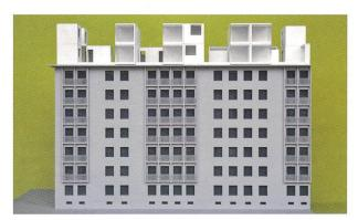
Maquette montrant le montage des modules 3D
