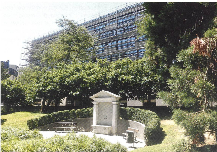
Les emménagements de cet immeuble de 113 logements se dérouleront en octobre. Il s'agit de la première réalisation de l'écoquartier de la Jonction. © Borcard
