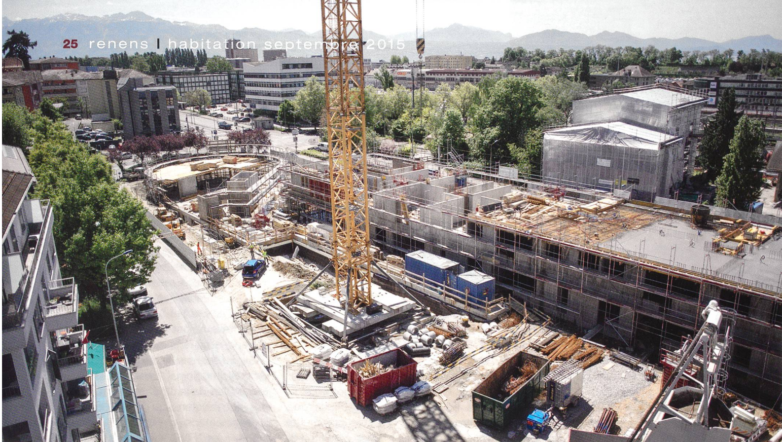
Le chantier de La Croisée / DR
