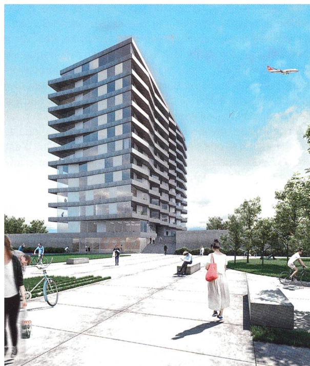
La future tour des Ailes dans l'écoquartier Les Vergers à Meyrin ©Aeby-Perneger & Associés
