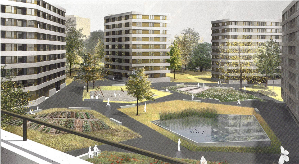
Démarrage en mai-juin d'une réalisation de 63 logements, préambule à la réalisation du projet Papillon (550 logements) sur le site emblématique de la SCHG, près de la Servette. ©Timothée Giorgis Architectes
