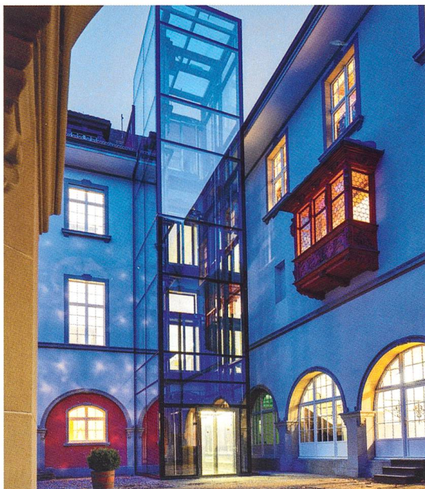
Musée d'histoire et du folklore de Saint-Gall: la modernité de la cage d'ascenseur en verre contraste avec le bâtiment historique.
