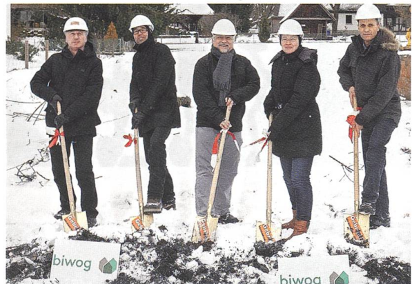
Coup de pioche avec des représentants de la biwog et des architectes. De gauche à droite Beat Gyax, bauart Architectes / Thomas Furrer, responsable de la commission des constructions biwog / Vincent Studer, président de la coopérative biwog / Susanne Rihs, Kaufmann Architectes / Thomas Bachmann, vice-président de la coopérative biwog.
