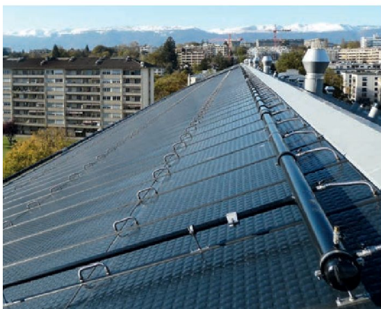
Capteurs solaires thermiques non-vitrés terminés sur Vidollet
