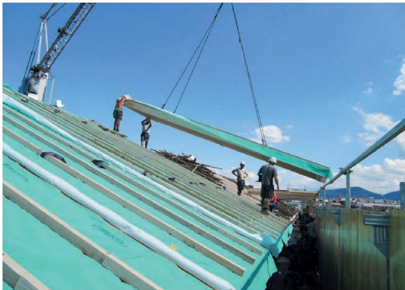
Pose d'un élément préfabriqué de toiture
