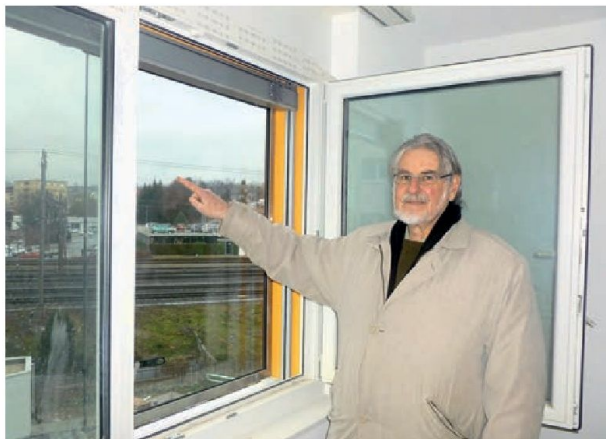
Le président de la SCILMO, Christophe Bonnard, désigne le vitrage de la «chicane à bruit», un dispositif qui permet d'aérer une pièce tout en offrant une protection contre les désagréments causés par un important axe ferroviaire. © VB
