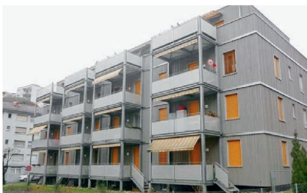
L'immeuble 46-48 rue de la Borde après rénovation. © VB
