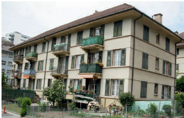
L'immeuble 46-48 rue de la Borde avant rénovation. © Christophe Bonnard
