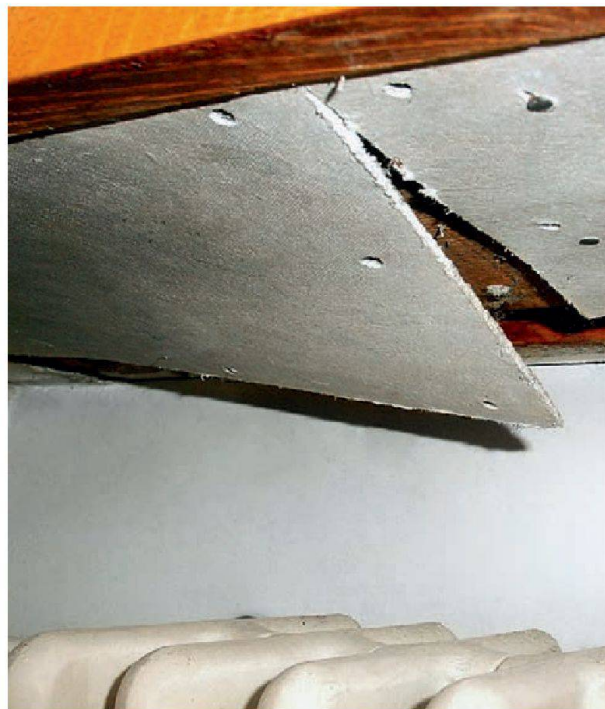
Aujourd'hui encore, dans les immeubles construits avant 1990, l'amiante peut se trouver dans des de nombreux endroits: ici au-dessus d'un radiateur.
