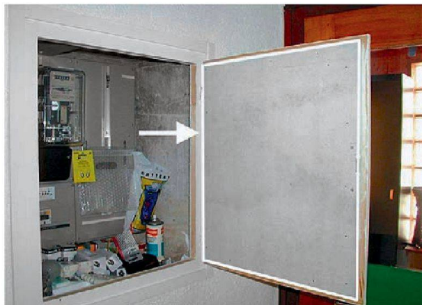
L'amiante permettait notamment d'isoler les portes des tableaux électriques.
