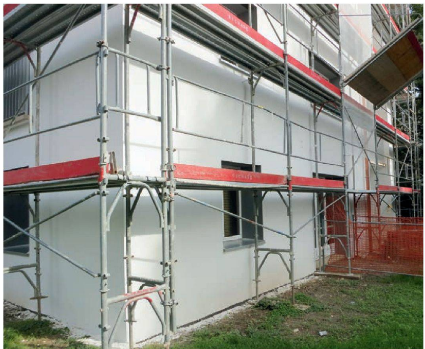
L'intervention est complétée par l'application d'un crépi fin. © Widmer architectes
