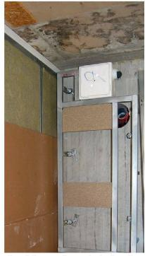
La solution pour les parois de séparation entre les appartements: construction à double ossature, parée de Knauf Silentboard, avec des valeurs d'isolation jusqu'à 10 dB supérieures. © Knauf AG, Reinach
