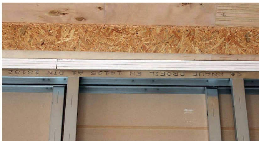
Raccord au plafond découplé sur le plan acoustique, plus cloisons de séparation à double ossature et Silentboard, également dans des locaux industriels.
