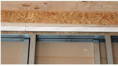
Raccord au plafond découplé sur le plan acoustique, plus cloisons de séparation à double ossature et Silentboard, également dans des locaux industriels.
