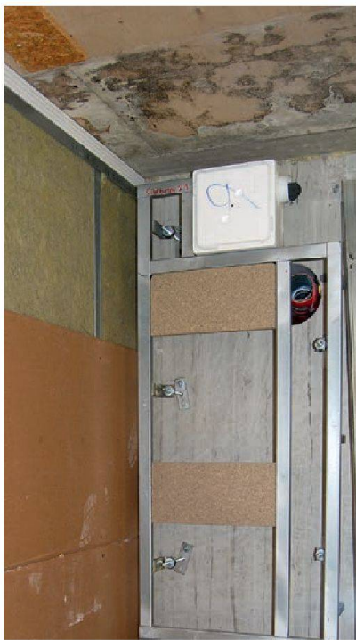
La solution pour les parois de séparation entre les appartements: construction à double ossature, parée de Knauf Silentboard, avec des valeurs d'isolation jusqu'à 10 dB supérieures. © Knauf AG, Reinach
