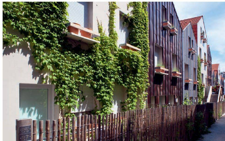
La petite venelle qui circule entre les façades pignons et les grands pots aux fenêtres, que les habitants peuvent utiliser comme bon leur semble. © Nicolas Castet
