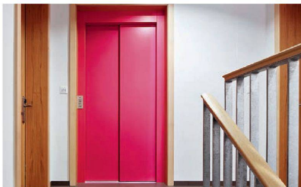
Les portes d'ascenseur de couleur rose confèrent une touche pimpante à la cage d'escalier. © Markus Beyeler
