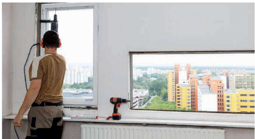
Les nouvelles fenêtres avec vitrage isolant. © Gesobau
