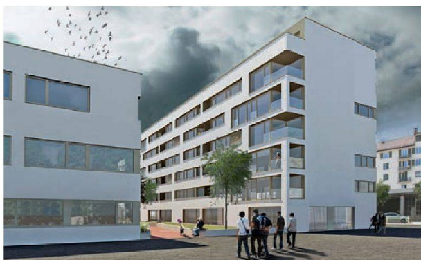
Ilôt B du quartier Le Corbusier, vue vers l'est.
