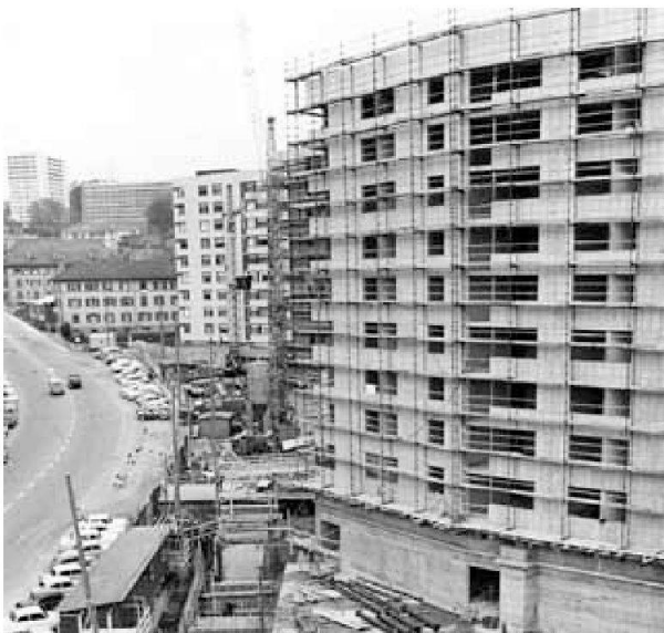
Frédéric Brugger, tours de la Borde (1960-1968) à Lausanne, vue du chantier (photo Erling Mandelmann, Pully)
