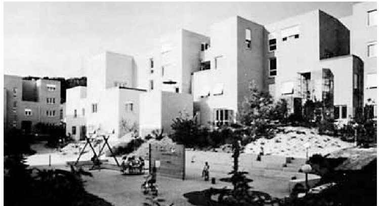
AAA (Alin Décoppet), logements à but social Grangette – Praz-Séchaud (1969-1977), Lausanne, vue extérieure
