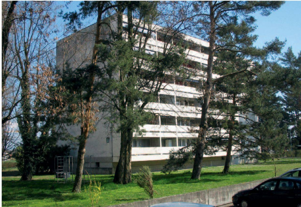
L'immeuble de la Casanostra Verein à Bienne.
