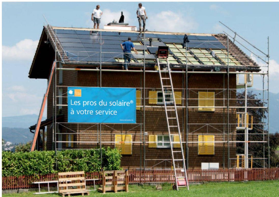
*Installation d'un système solaire combiné, avec la pose de photovoltaïque pour l'électricité et de thermique pour le chauffage.*
