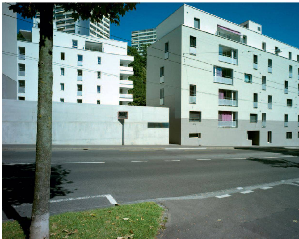
Les façades Ouest donnant sur la rue de la Borde. A droite, l'un des bâtiments en L et au fond le bâtiment qui abrite les logements protégés. © Atelier Cube
