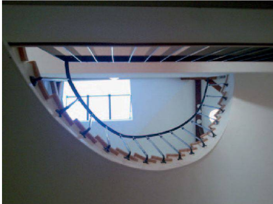
Cage d'escalier rénovée.
