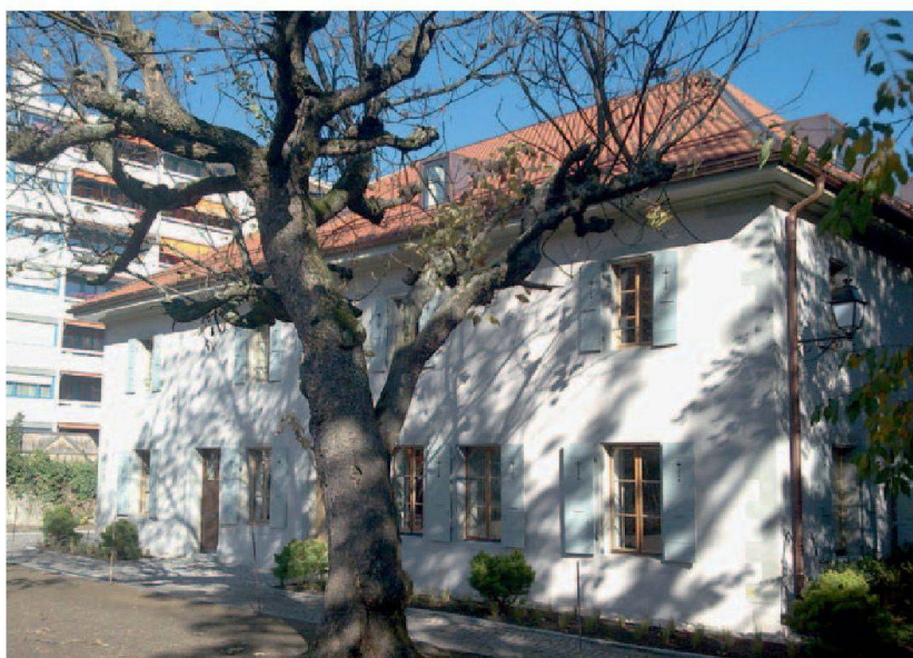
Clos Voltaire: façade sud-est après rénovation.
