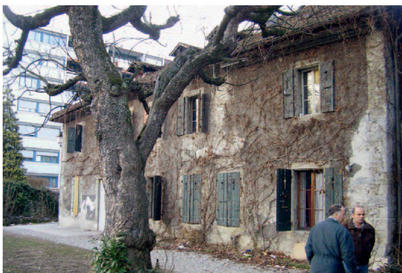
Clos Voltaire: façade sud-est avant rénovation.
