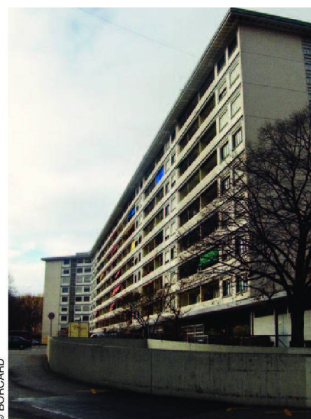
L'immeuble de la SCHG au chemin des Sports 2-16, audité par EPIQR.
