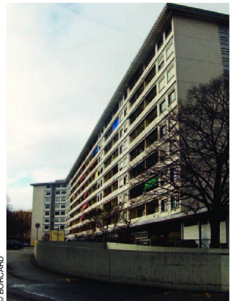
L'immeuble de la SCHG au chemin des Sports 2-16, audité par EPIQR.
