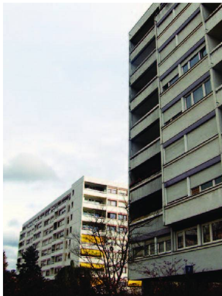
Des rénovations doivent être entreprises sur les grands locatifs de la Cité Vieusseux.
