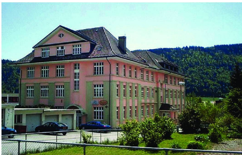
Le bâtiment de l'ancienne manufacture de harpes est en excellent état.
