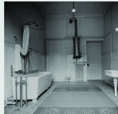
Une salle de bain aménagée dans un immeuble à Zurich en 1826-29.
