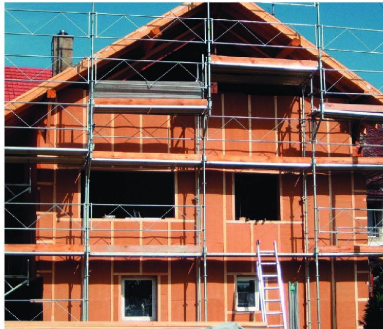
Isolation en fibres de bois avant la pose d'un coupe-vent et d'une façade ventilée.
