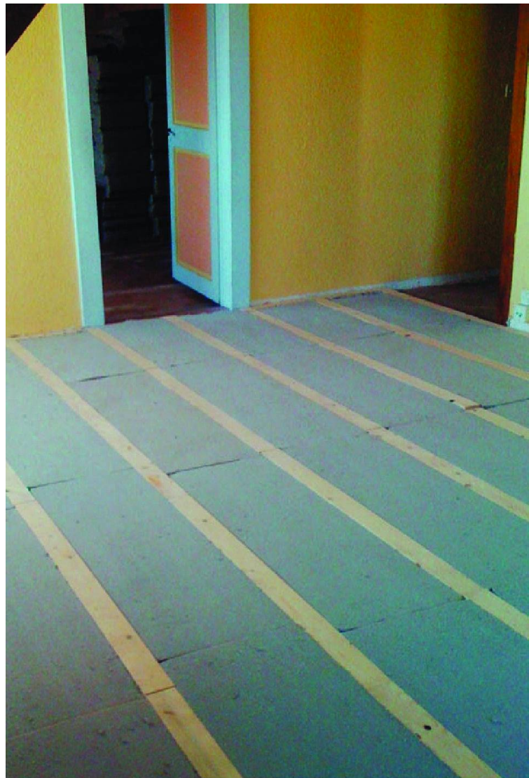
Isolation phonique d'un sol en ouate de cellulose en plaques (système Homatherm silentTop) avant la pose d'un plancher flottant.
