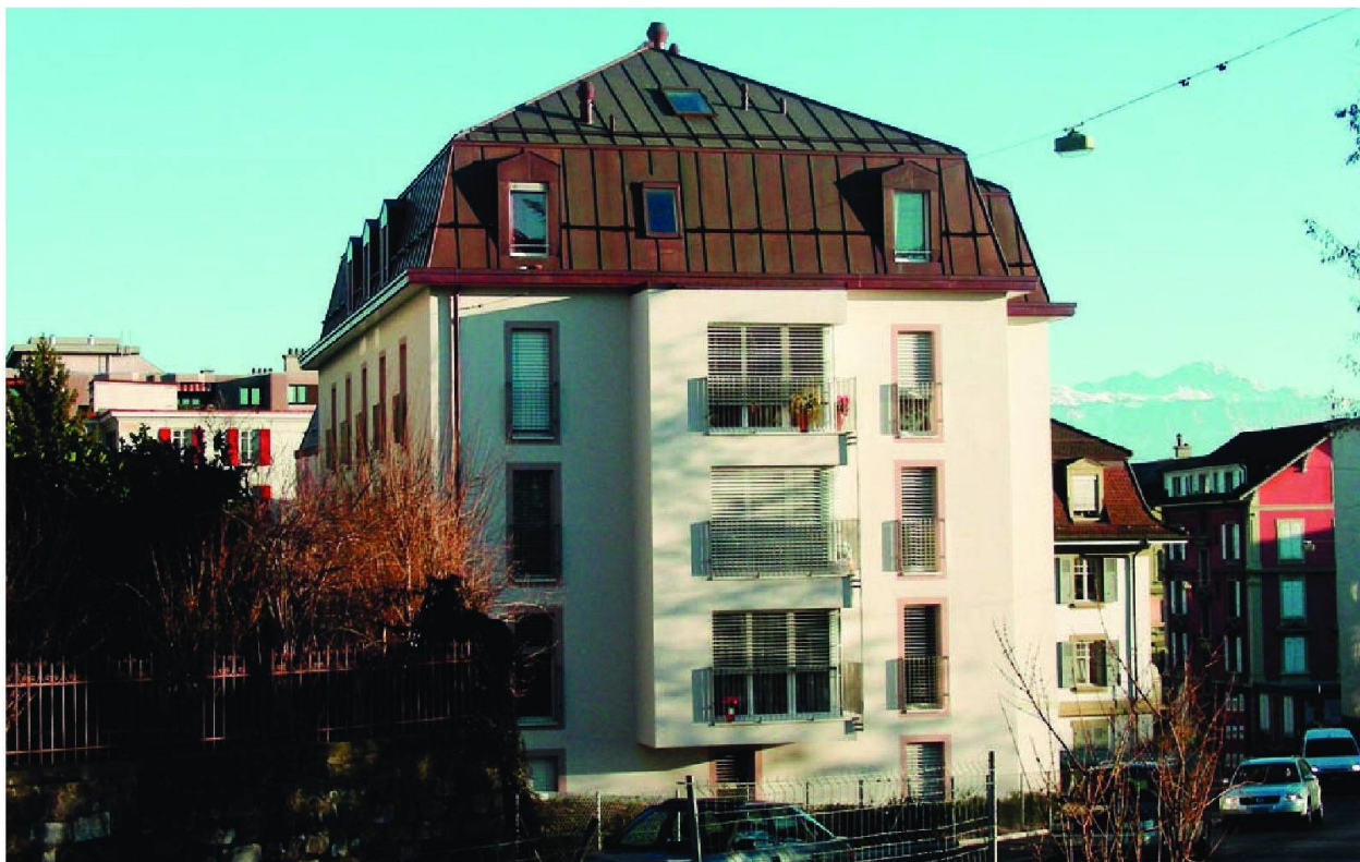
L'immeuble de la coopérative Logement Idéal à l'avenue Recordon à Lausanne.
