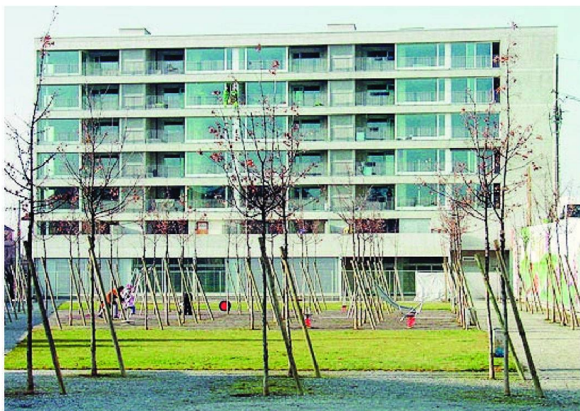
L'immeuble de la coopérative Logement Idéal à l'avenue d'Echallens à Lausanne.
