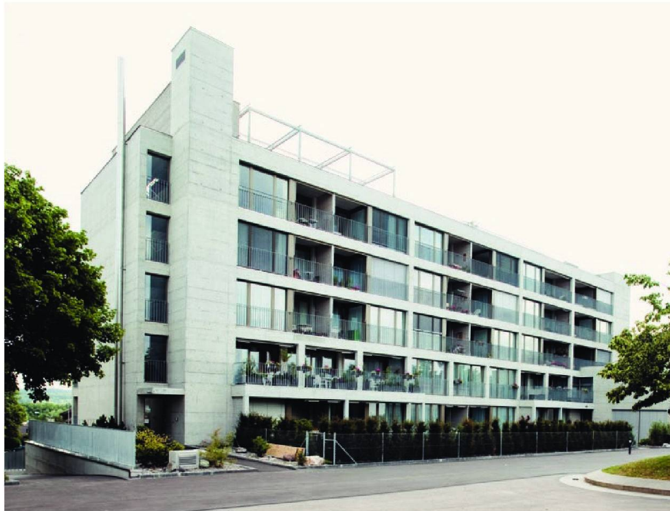
La façade sud-ouest, avec ses loggias, donne sur la tranquille place du village.
