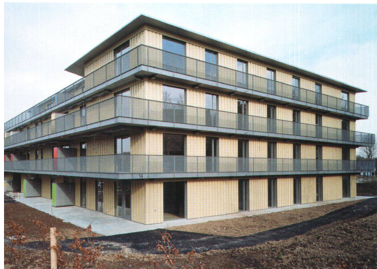
Le coffrage de façades en panneaux de bois peints en jaune et les coursives entourant les immeubles de part en part donnent une identité forte à l'ensemble.
