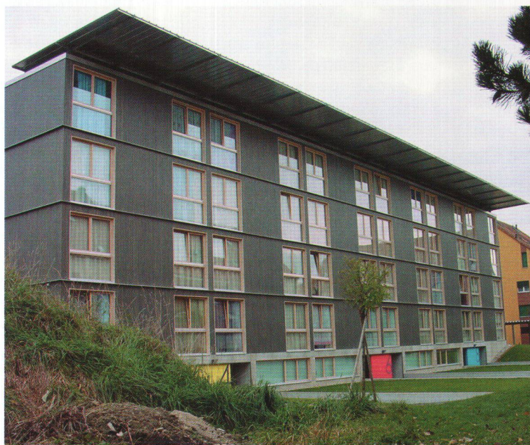
L'immeuble tout en bois également à Yverdon-les-Bains, avec ses entrées colorées bien marquées.
