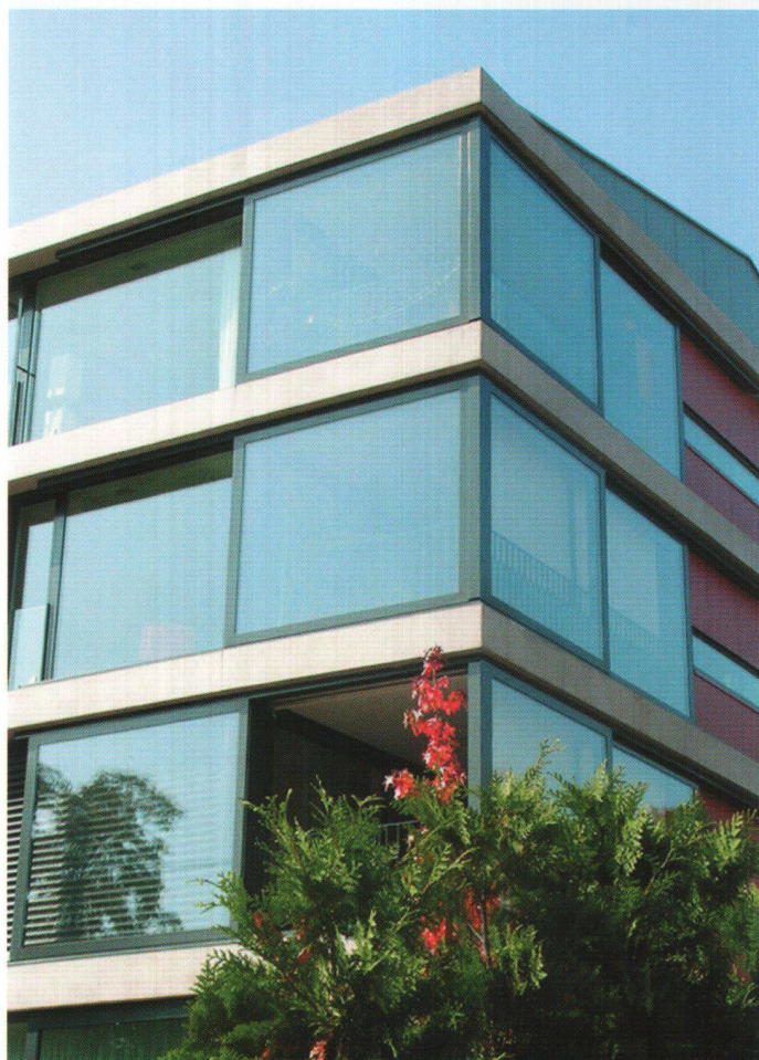
Taille maximale des surfaces vitrées grâce à du verre isolant et à une protection solaire extérieure, orientable. Les fenêtres peuvent être entièrement rabattues.
