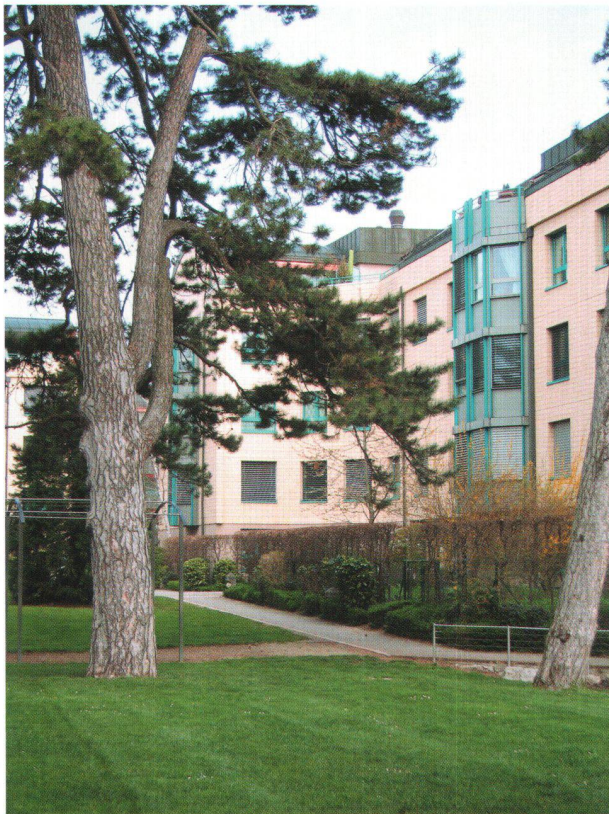
Dessus, le face-à-face des anciennes maisons rénovées de la Cité jardin et des «nouveaux» immeubles, rue Essor. Dessous, vue sur la pelouse et ses pins, qui prolonge à angle droit la place des fontaines.
