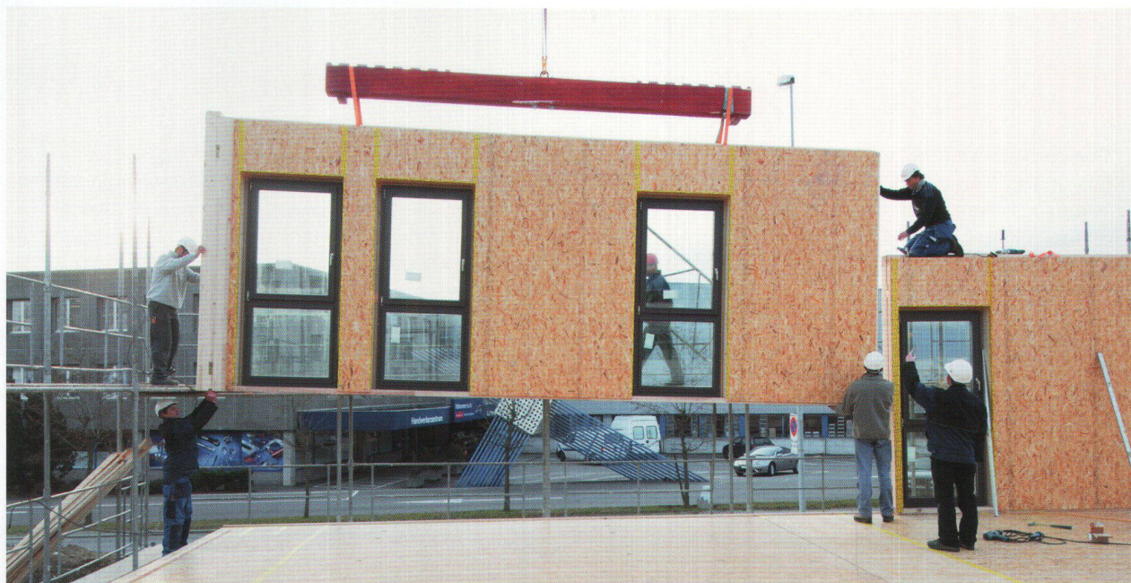
Montage des parois du rez-de-chaussée.
