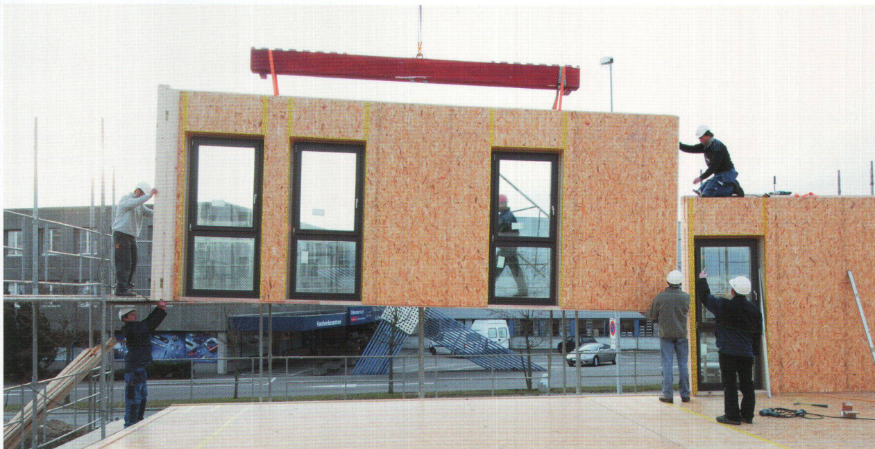
Montage des parois du rez-de-chaussée.
