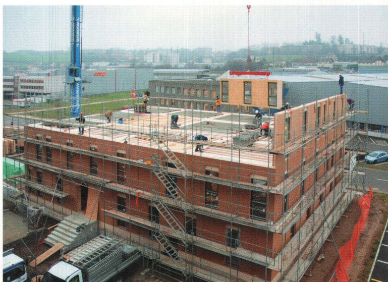
Montage des parois du troisième niveau.
